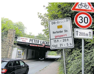
Seit Sonntag ist die Bahnunterführung an der B239 von 21 Uhr bis 5 Uhr morgens für Autos gesperrt. Foto: Björn Kenter
