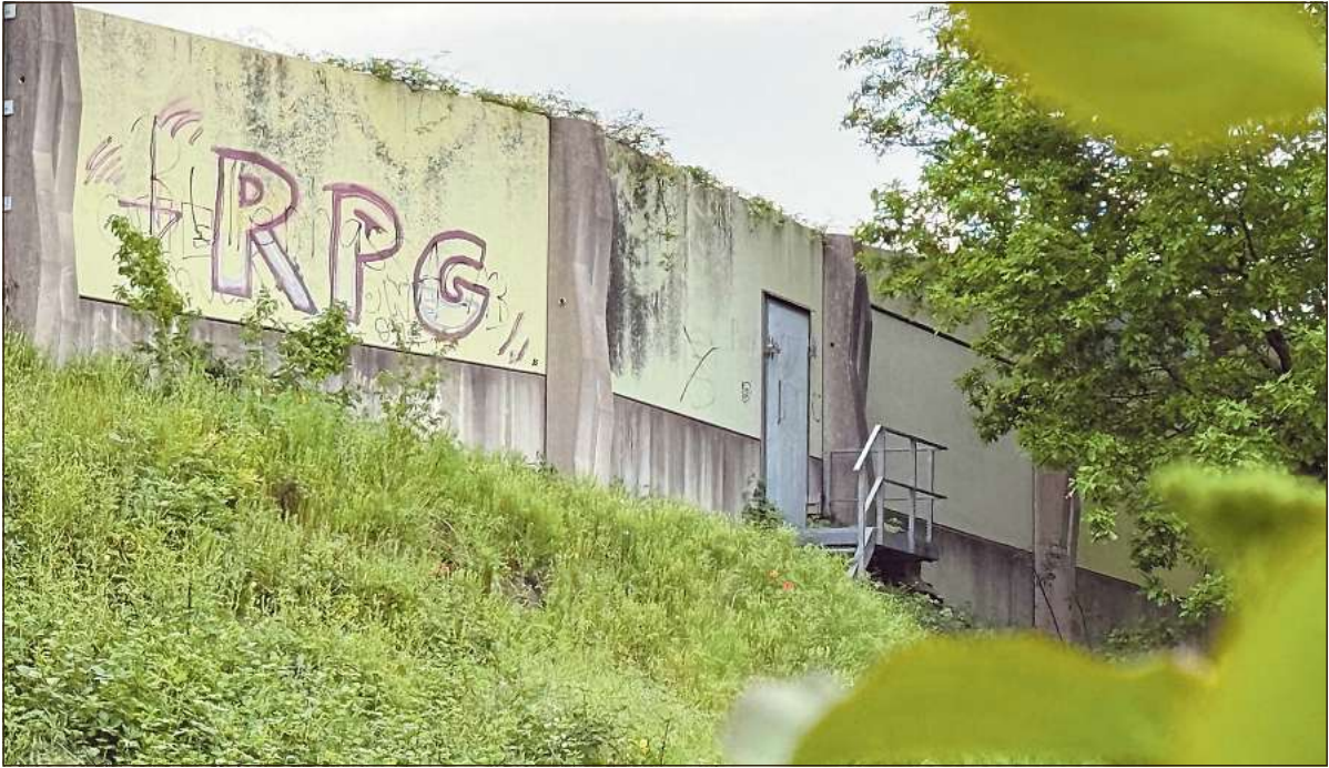
Durch eine Tür wie diese, die sich im Abstand von 500 Metern in den Lärmschutzwänden befinden, ist der Steinwerfer wohl auf die A2 gelangt. Aus Sicherheitsgründen stehen die Türen in der Regel offen, heißt es von der Autobahn-GmbH des Bundes. Unser Foto entstand am Bahnradweg. Foto: Sudbrock
