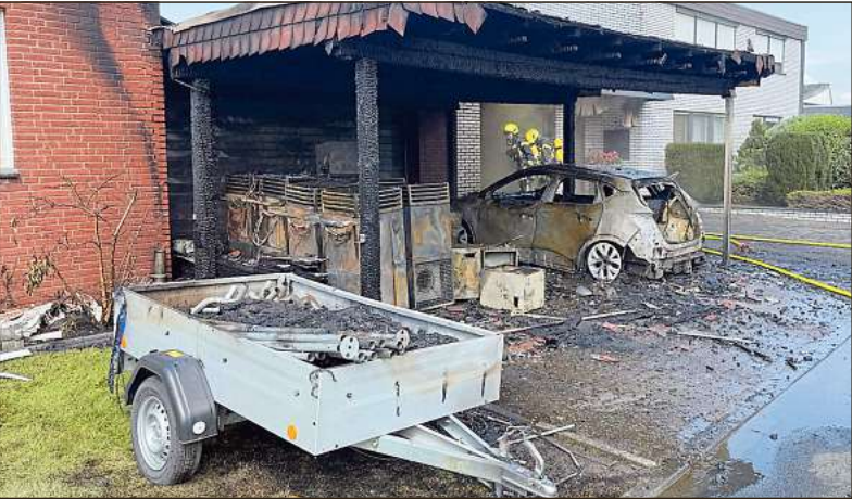
Die angrenzenden Wohnhäuser wurden durch den Carport-Brand in einer St. Viter Wohnsiedlung in Mitleidenschaft gezogen.
